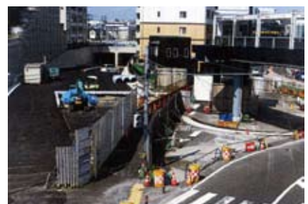
大踏切アンダーパス工事
